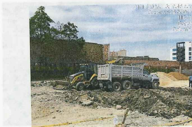
Retiro de material excavado en bloque 7. Fecha: 21-11-2023.
