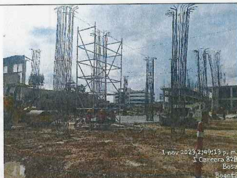
ARMADO DE ACERO COLUMNAS NIVEL 11,80 BLOQUE 1 - 01/11/2023
