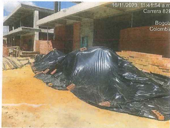
Protección de materia granular acopiado en obra. Fecha: 16-11-2023.
